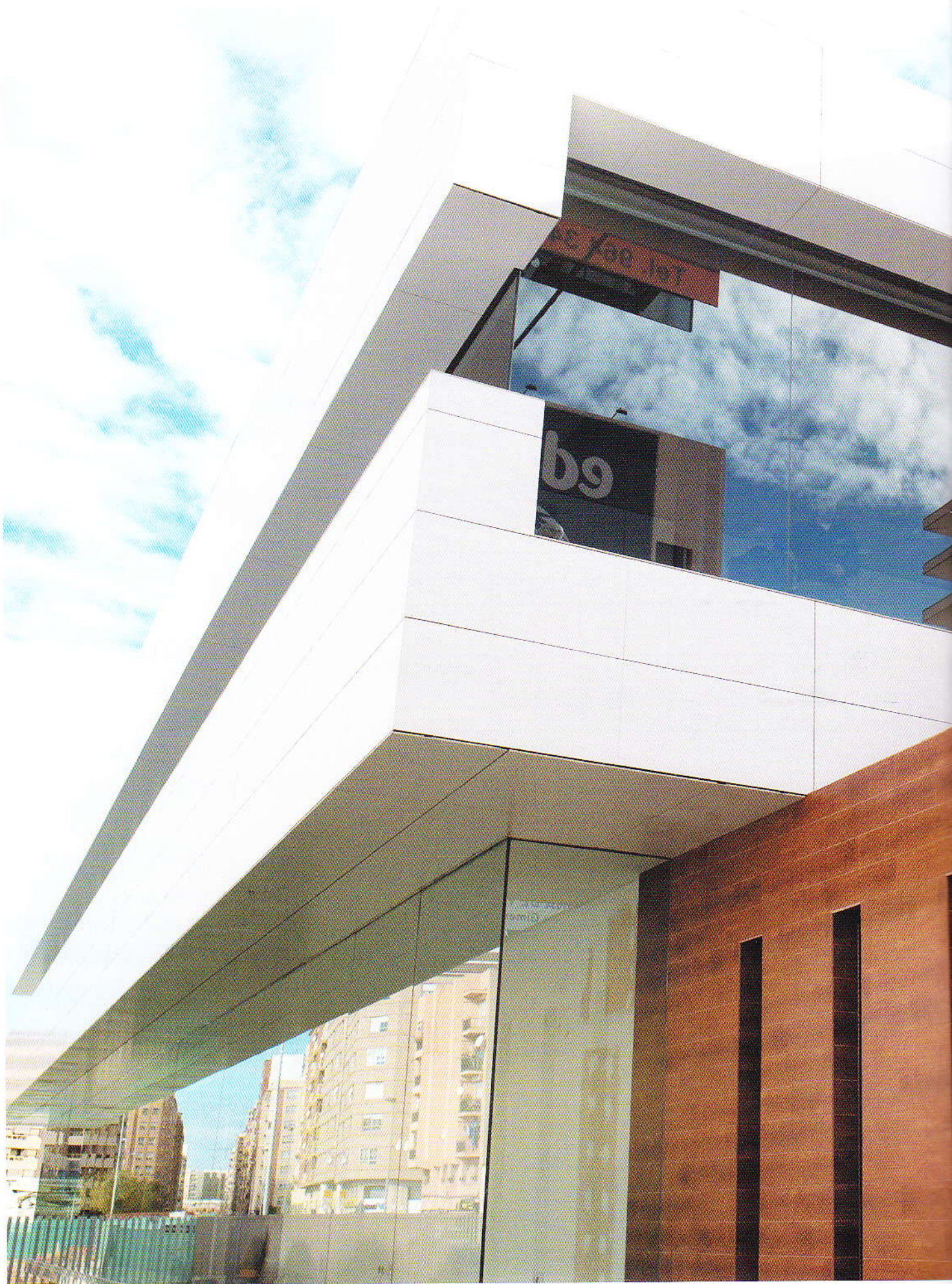
Fachada ventilada oficinas edificio Domenech (Castellón).
